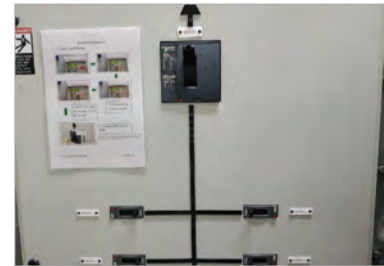
รูปที่ 4 ตัวอย่างตู้ SL-MDB1 และอุปกรณ์ตัด/ ต่อการจ่ายไฟฟ้า (Circuit Breaker)
