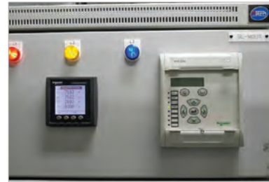
รูปที่ 3 ตัวอย่างอุปกรณ์ Protection Relay ที่ใช้แสดงผลในสภาวะปกติ / ความผิดปกติของระบบ Solar cell
